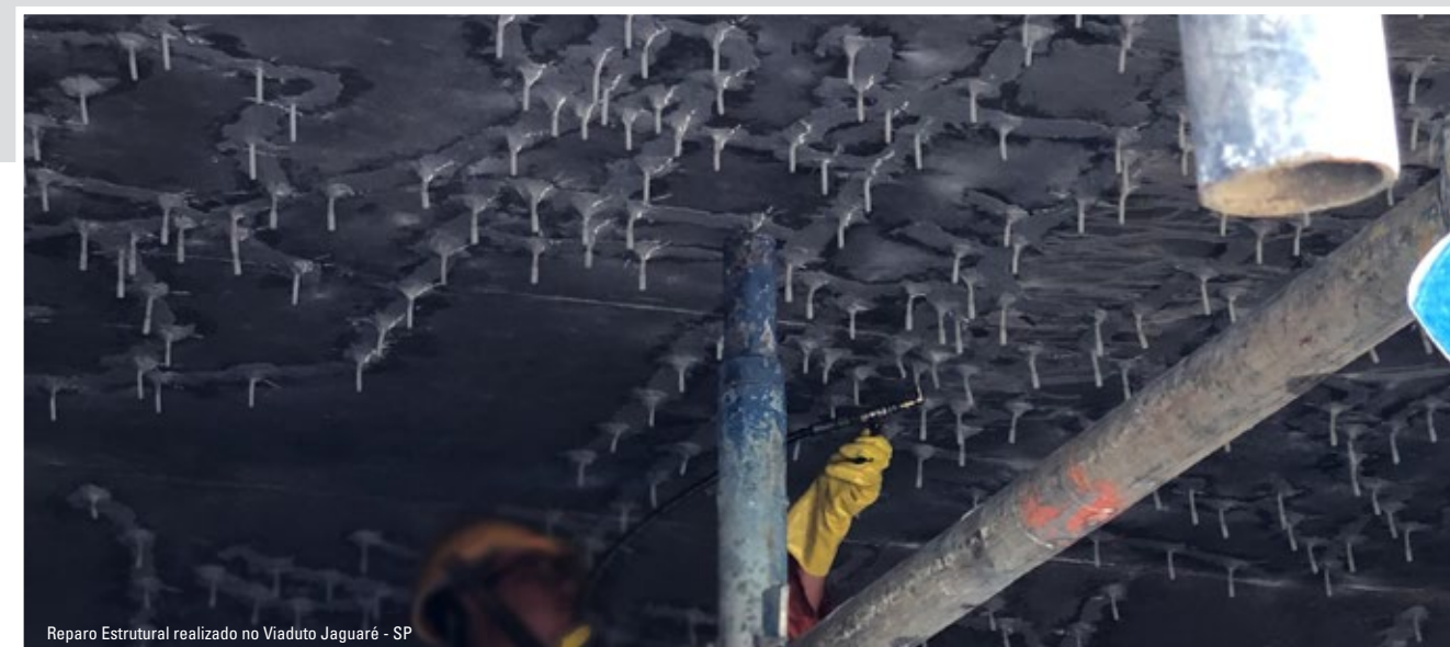
Reparo Estrutural realizado no Viaduto Jaguaré - SP
